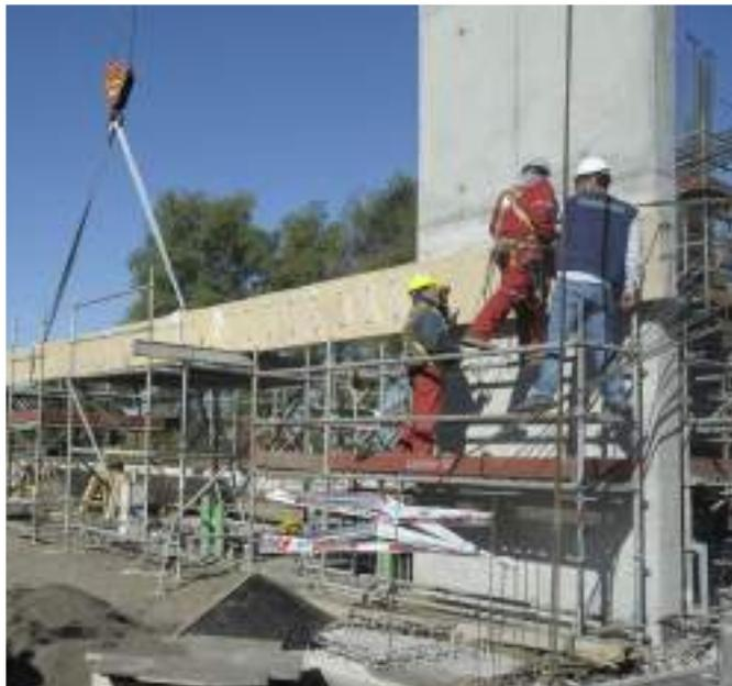
Fotografías / Primera viga de madera laminada instalada en nuevo edificio corporativo.
