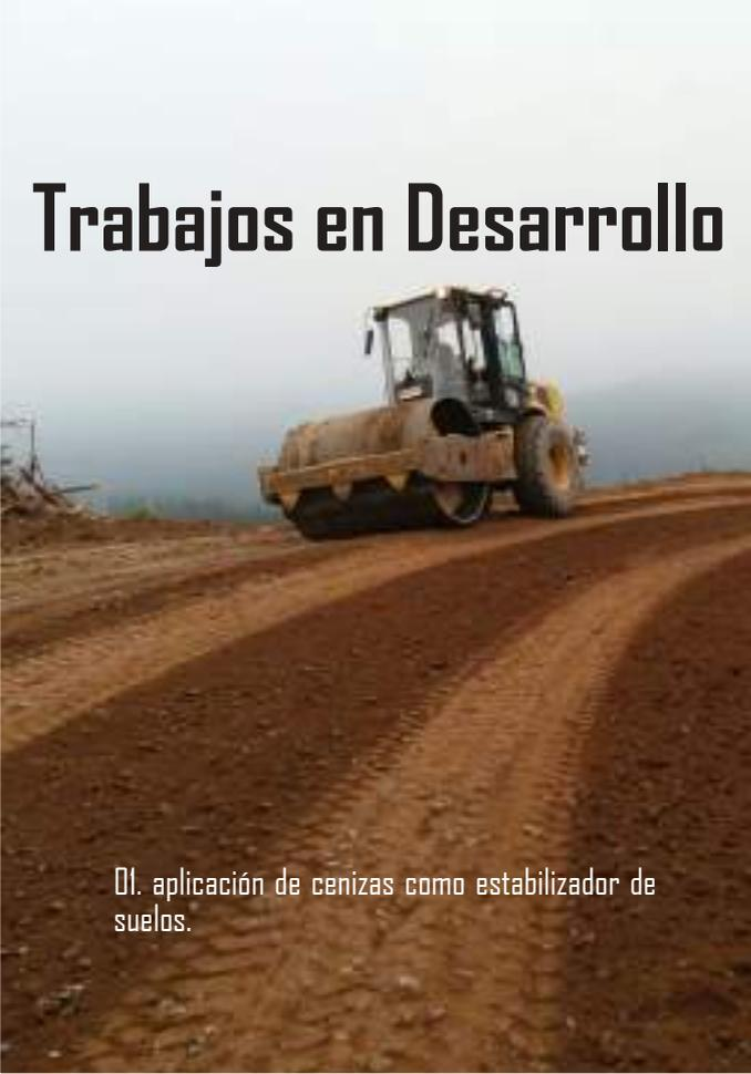
01. aplicación de cenizas como estabilizador de suelos.
