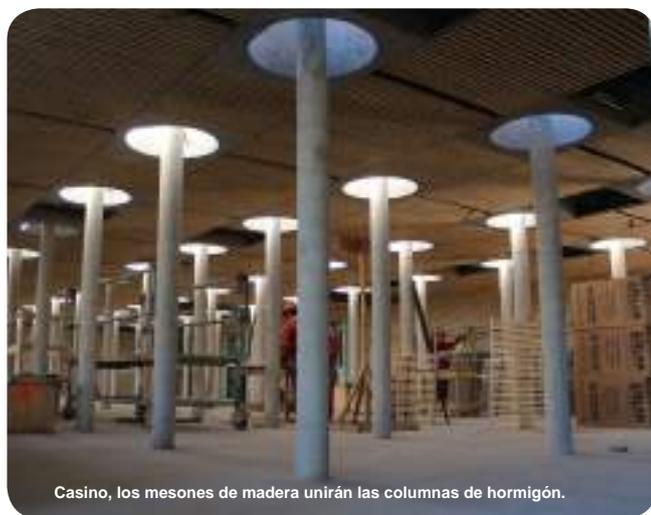
Casino, los mesones de madera unirán las columnas de hormigón.
